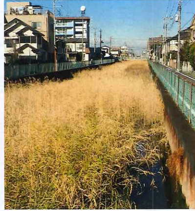
葛西用水(施工前)
